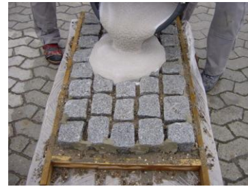
Afb. 6: aanbrengen op de bestrating
