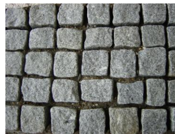
Afb. 2: voegen die zijn voorbereid
