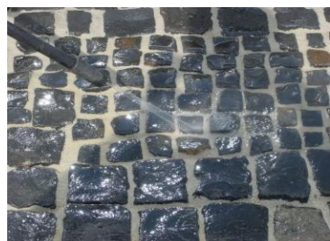
Afb. 9: afsproeien van het oppervlak
