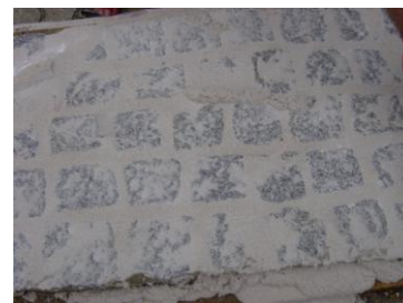
Afb. 7: bestrating met aangebrachte mortel.
