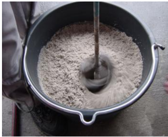
Afb. 4: mengen van de componenten
