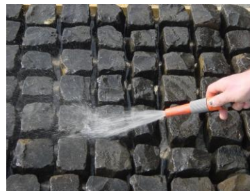
Afb. 1: Reinigen / voornatten
